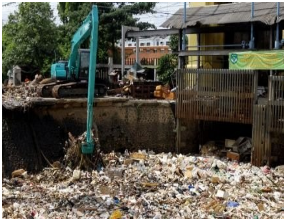
Sampah di pintu air Manggarai : Sampah plastik menggunung
